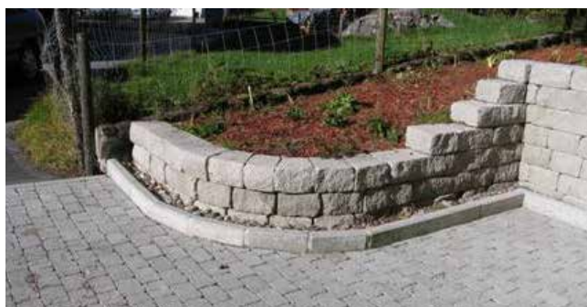
Bild 30: Maueraufbau mit SANTURO® Keilmauersteinen
