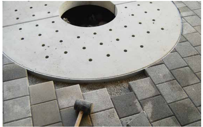
Versetzte TREETUB Betonabdeckung 2-teilig
