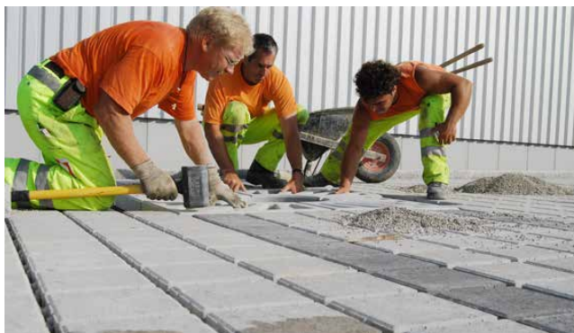
Versetzen der COMO Baumscheiben
