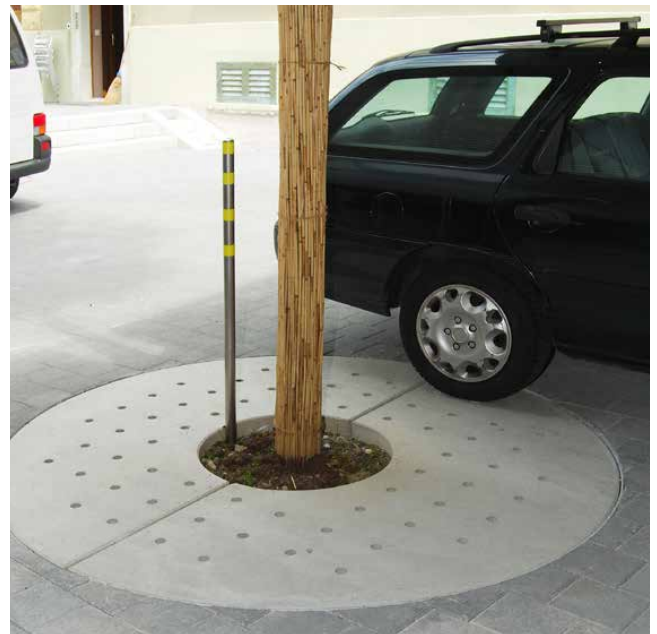
TREETUB Baumwurzelraumschutz mit Betonabdeckung
