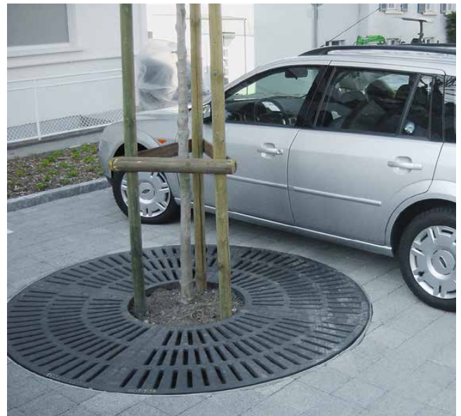
TREETUB Baumwurzelraumschutz mit Gussrost
