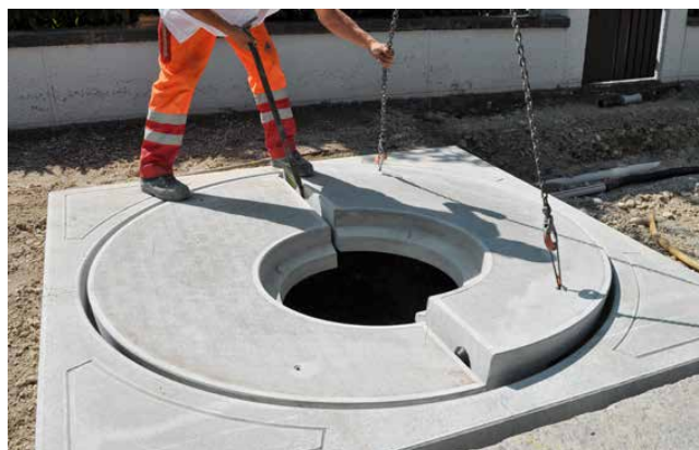
Versetzen der COPAL® Betonabdeckung
