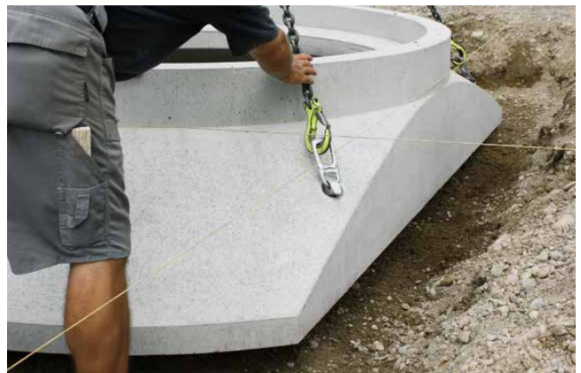
Versetzen des Basiselementes
