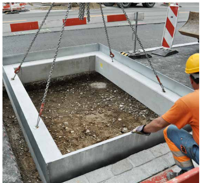
Versetzen des BAUMFIX® Kombirahmenelementes
