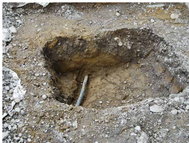
Werkleitungen stören das Wachstum der Baumwurzel
