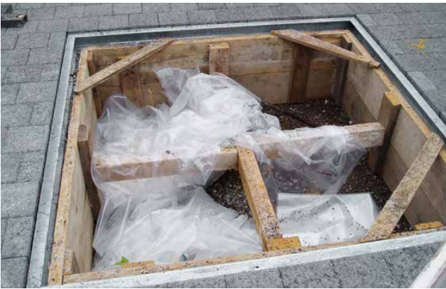
Eingebauter Stahlrahmen als Baumkranz
