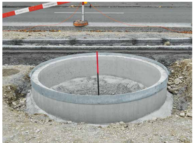
Montierter Stahleinbaurahmen mit Bolzenanker
