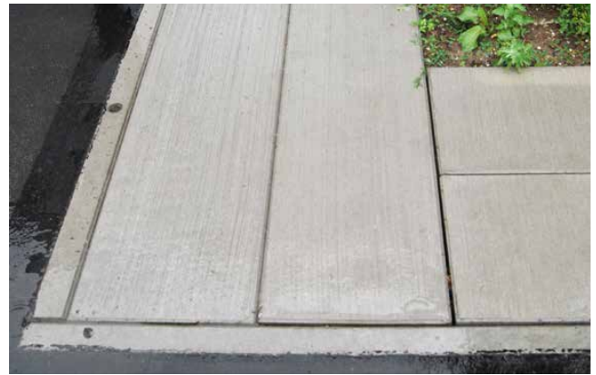
Wasserzufuhr durch Fugen
