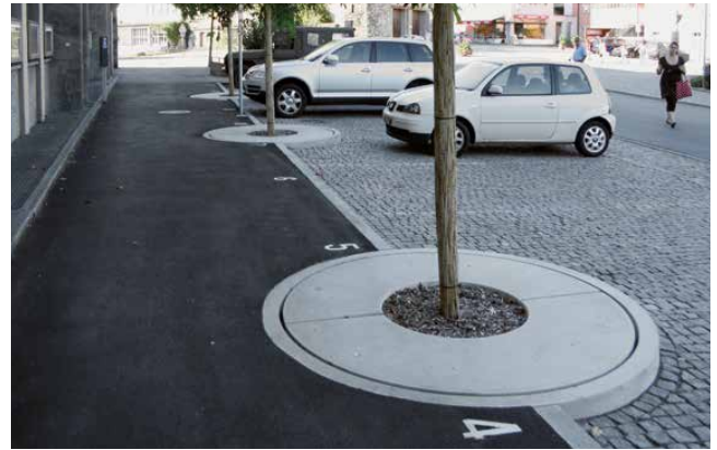
Anlegen von Hochborden
