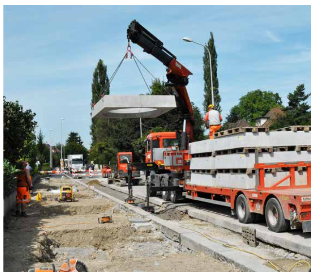
Transport auf der Baustelle mit Lieferfahrzeug
