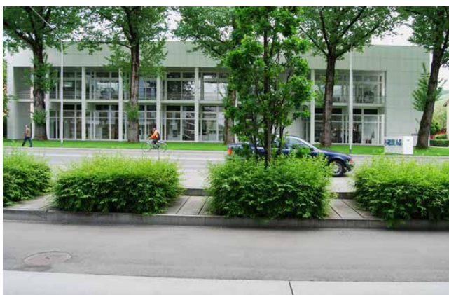
Einbau von Verbindungen zwischen den Baumgruben
