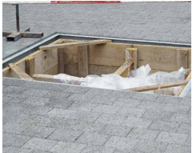
Pflanzengrube mit Fundament und Stahlrahmen
