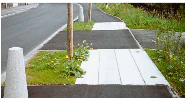
Wurzelbrücke mit Wehrsteinen als Anfahrtschutz
