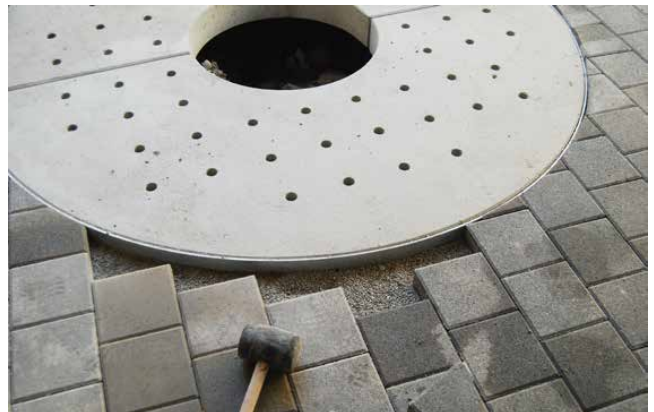
Versetzte TREETUB Betonabdeckung 2-teilig
