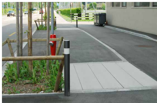
Einbau von Wurzelbrücken seitlich der Baumgrube
