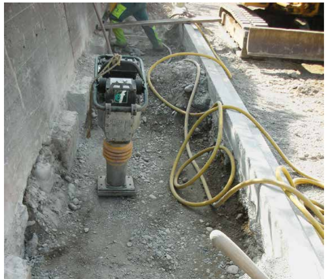
Sohle für die Versetzung der Fundamente
