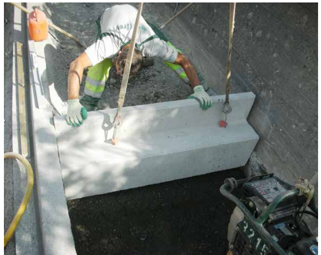
Versetzen des F+F Fertigfundamentes
