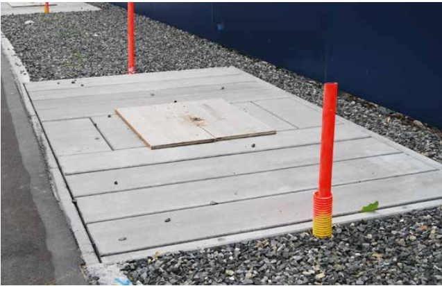
Einbau von Bewässerungs- und Belüftungsleitungen
