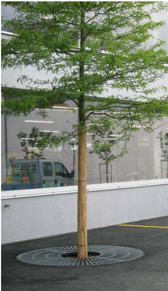
TREETUB Baumwurzelraumschutz mit Gussrost
