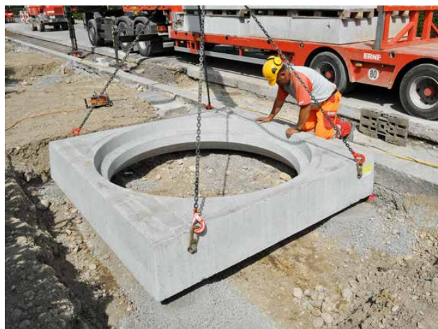
Versetzen des COPAL® QUADRO Basiselementes
