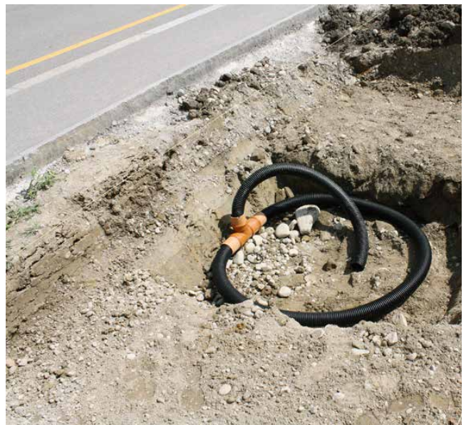
Vorbereitete Sickerrohre in der Baumgrube
