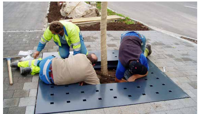
Montieren der Verbindungsschrauben
