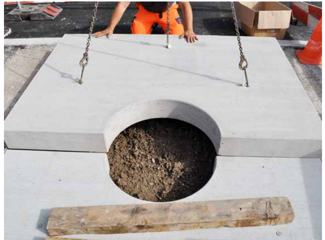
Versetzen der BAUMFIX® Baumscheiben
