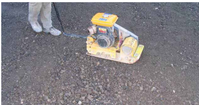
Bild 4: Verdichten der Fundationsschicht
