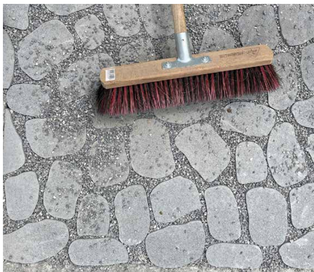
Bild 6: Einsanden der Fugen
