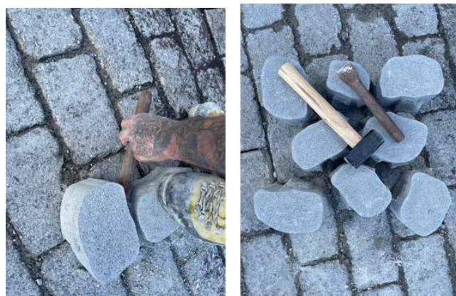
Bild 9: Auftrennen mit Steinsetzer und Fäustel in Einzelstücke
