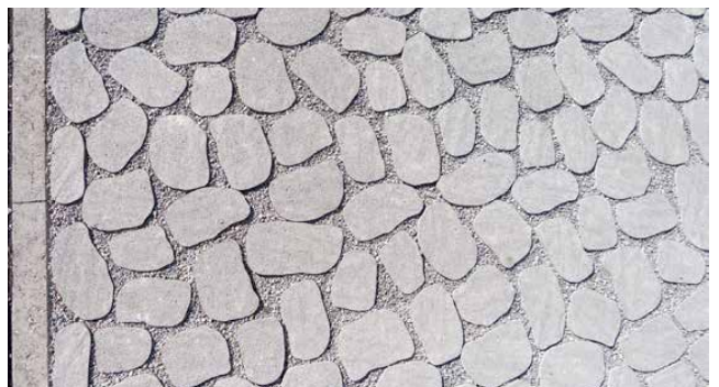
Bild 2: Eingesetzte Randstein entlang Stellplatten
