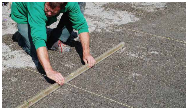
Bild 5: Abziehen der Bettungsschicht
