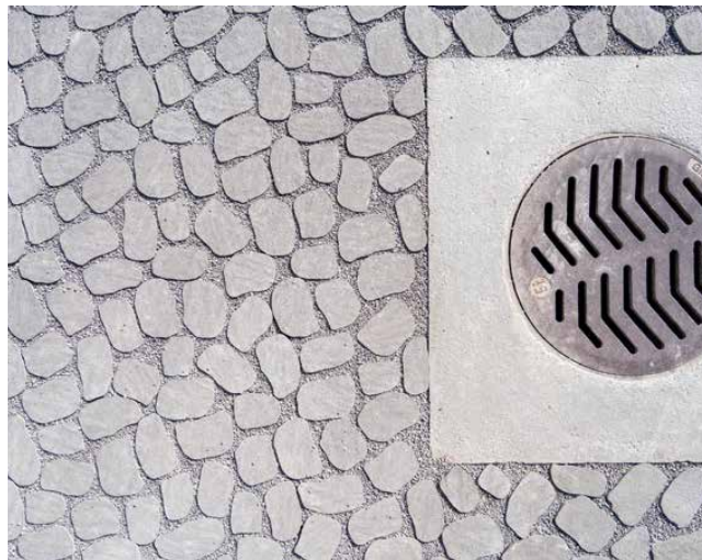
Bild 3: Einlaufschacht mit Betonkragen
