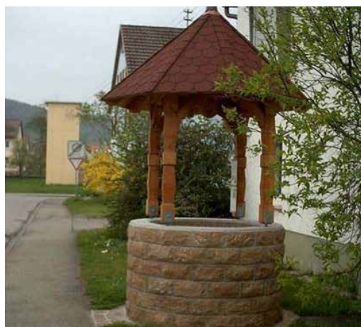
Bild 32: Brunnenbau mit SANTURO® Keilmauersteinen
