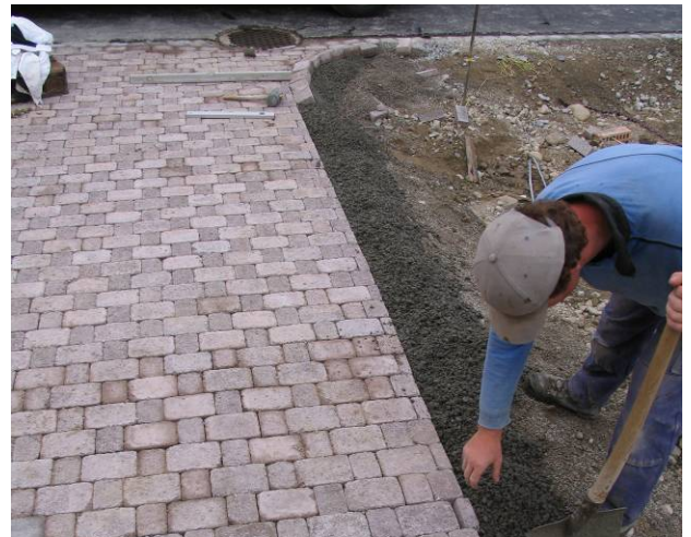
Bild 43: Erstellen des Randabschlusses
