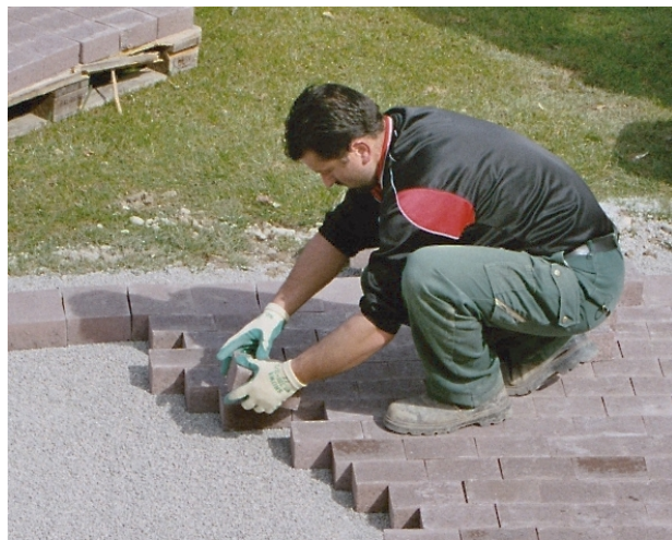
Bild 35: Verlegung der Steine von Hand
