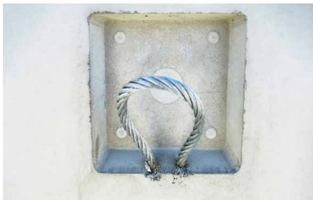
Bild 24: Werkseitig eingebaute Versetzschlaufen
