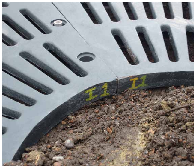
Einfaches Zusammensetzen des 4-teiligen Gussrostes mit den zusammengehörenden Markierungen
