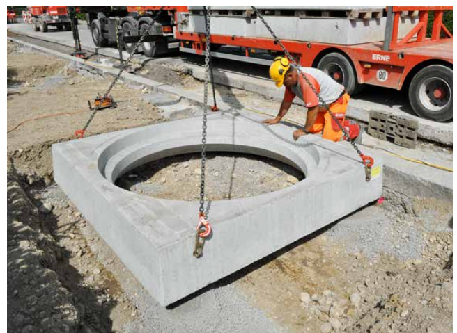
Versetzen des COPAL® QUADRO Basiselementes
