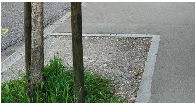
Ungeschützter Wurzelraum führt zu hoher Bodenverdichtung
