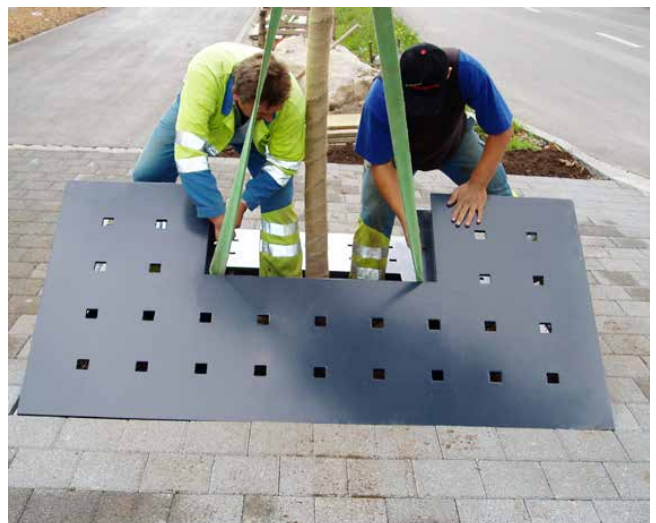
Versetzen der COPAL® STEEL Stahlbaumscheibe
