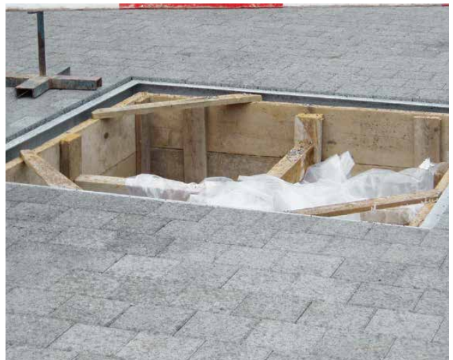
Pflanzengrube mit Fundament und Stahlrahmen
