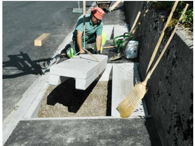
Versetzen der F+F Abdeckelemente
