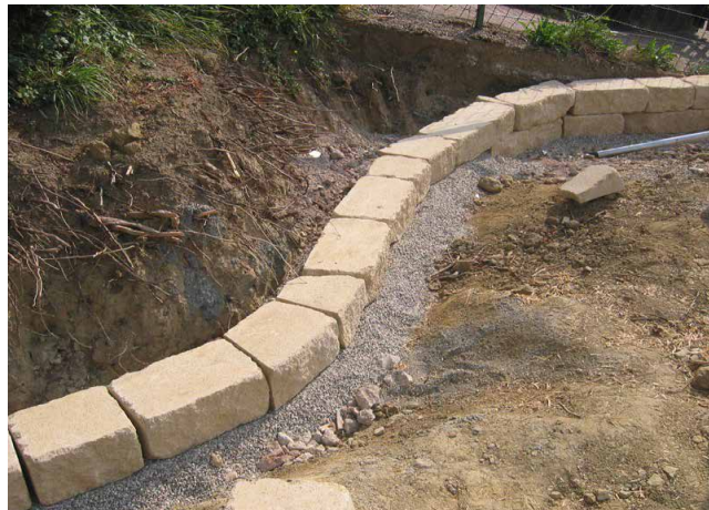
Bild 24: Versetzte erste Steinreihe in Kiesfundament
