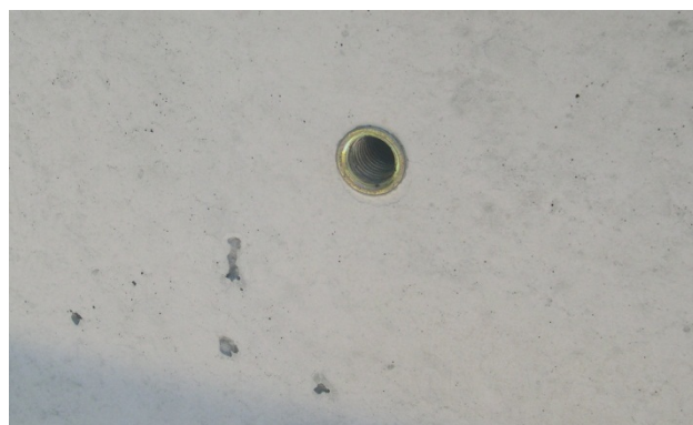
Bild 20: Werkseitig eingebaute Versetzhülsen
