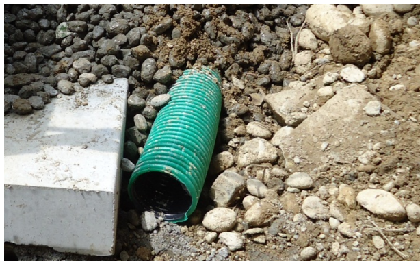
Bild 22: Einbau einer Sickerleitung
