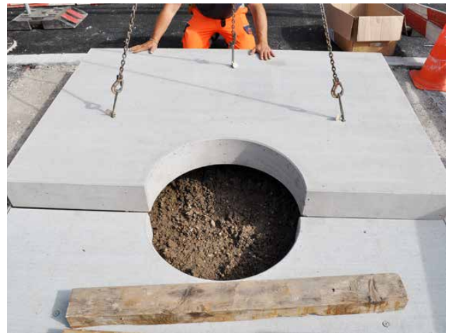
Versetzen der BAUMFIX® Baumscheiben
