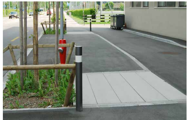
Einbau von Wurzelbrücken seitlich der Baumgrube
