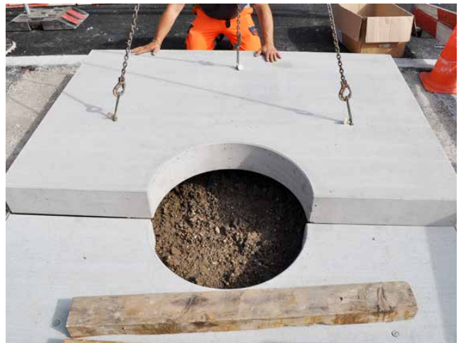
Versetzen der BAUMFIX® Baumscheiben
