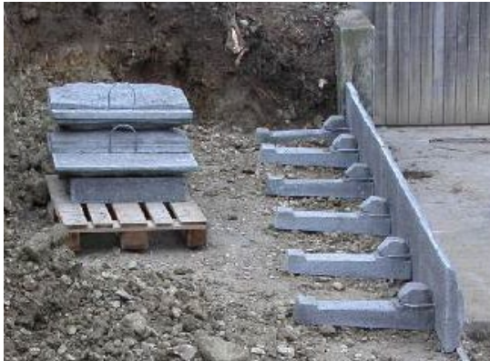
Bild 18: Verlegte Frontplatte mit Normalanker
