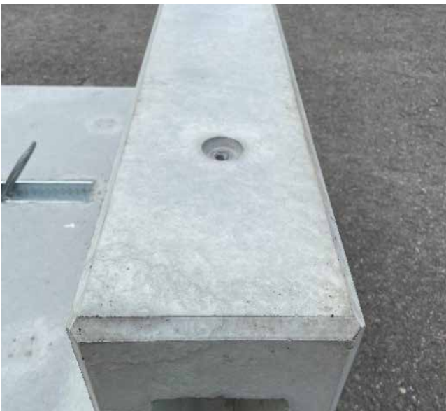
Werkseitig eingebaute Gewindehülsen
