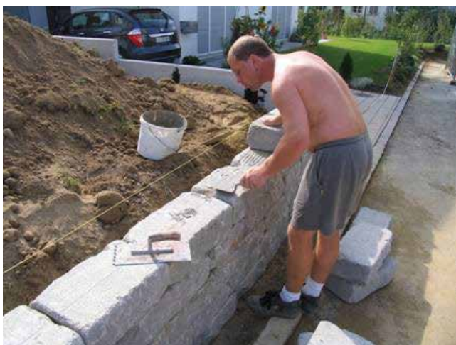
Bild 38: Mörteln der Fugen
