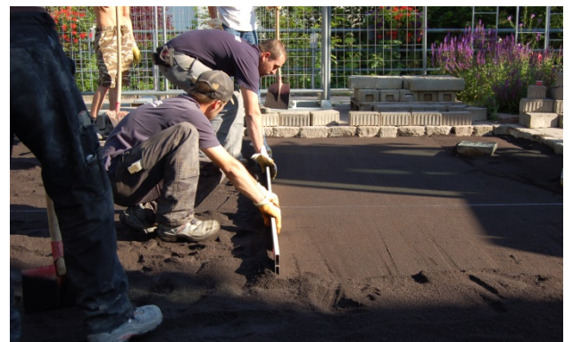
Bild 18: Mischgut abziehen
