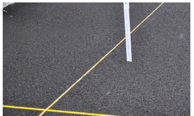
Bild 22: Kontrolle der Einbauhöhe
