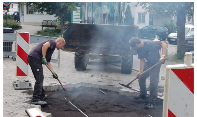
Bild 17: Mischgut muss gesetzt werden
