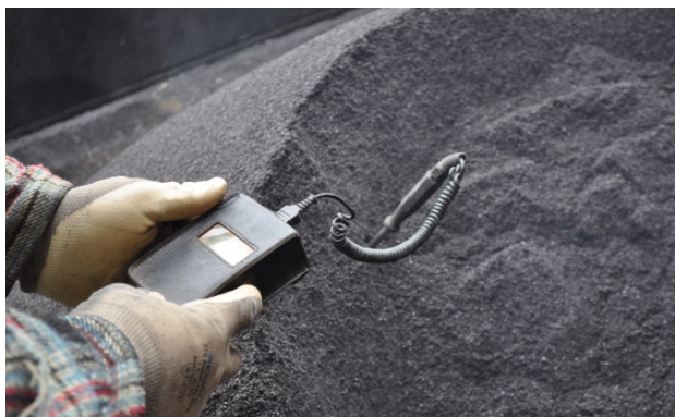
Bild 20: Kontrolle der Einbautemperatur
