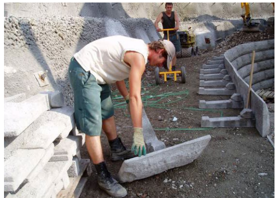
Bild 16: Frontplatte mit Anker verbinden
