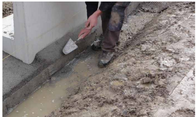
Bild 30: Erstellen der Fundamentnocken
