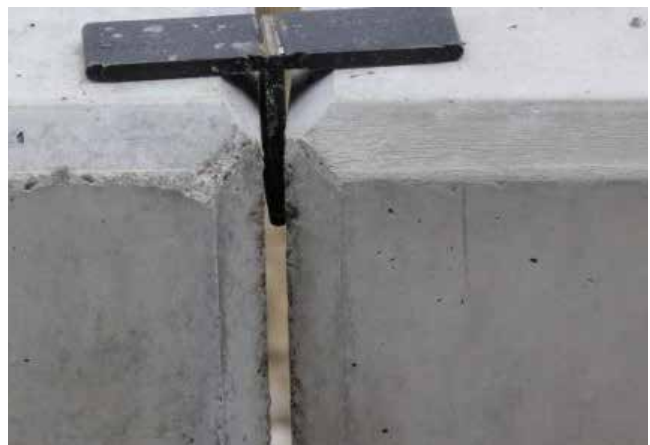
Bild 32: Optimale Fugen nach der Versetzung
