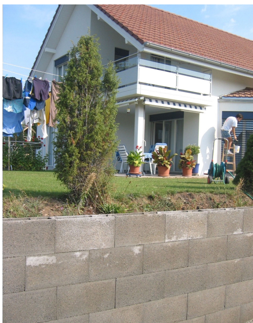
Bild 1: SCHALIT Schalungsstein als Hangsicherung
