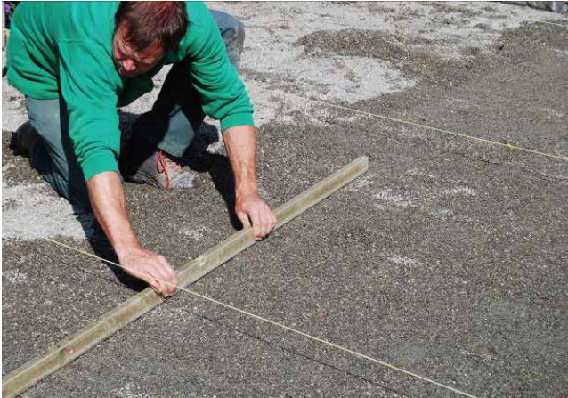
Abziehen der Bettungsschicht
