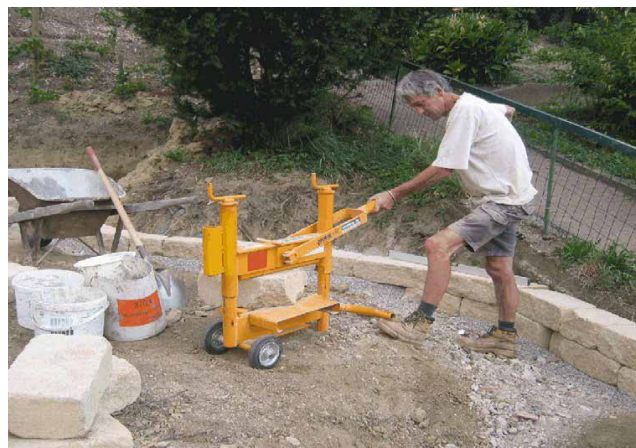
Bild 35: Arbeiten mit Steinspalter
