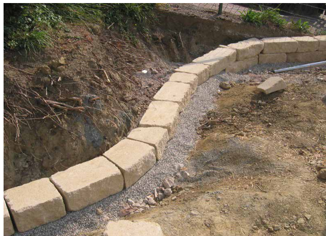
Bild 24: Versetzte erste Steinreihe in Kiesfundament
