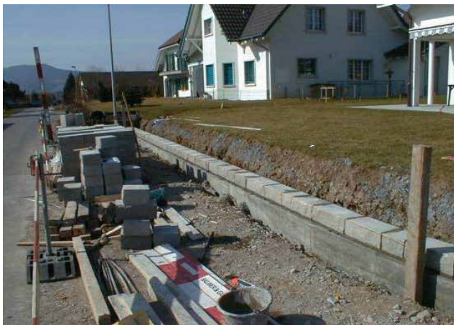
Bild 23: Versetzte erste Steinreihe in Betonfundament
