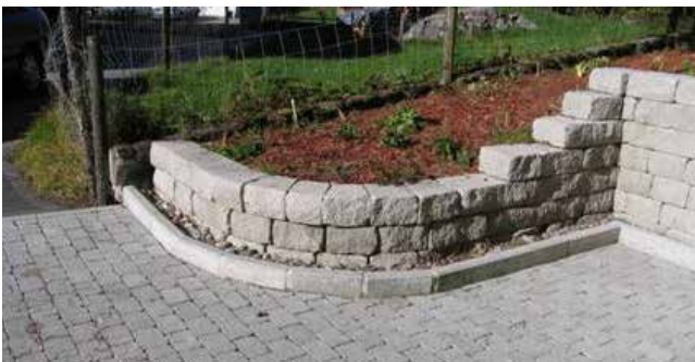
Bild 30: Maueraufbau mit SANTURO® Keilmauersteinen
