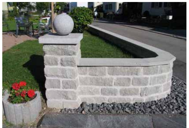
Bild 44: Versetzte SANTURO® Abdeckplatten in Segmente geschnitten
