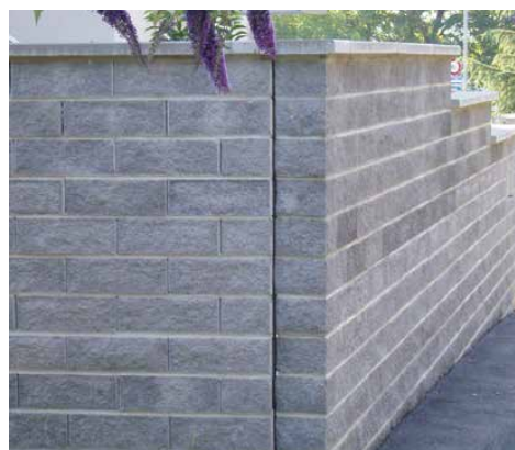
Bild 41: Dilatationsfuge (Produktneutral)
