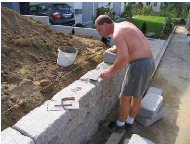
Bild 38: Mörteln der Fugen
