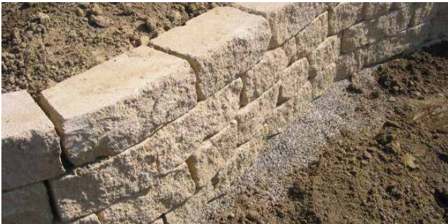
Bild 28: Kurvenbildung mit geraden Steinen
