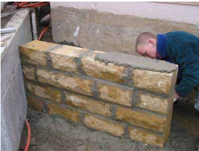
Bild 42 Aufbringen Mörtel für Abdeckplatte
