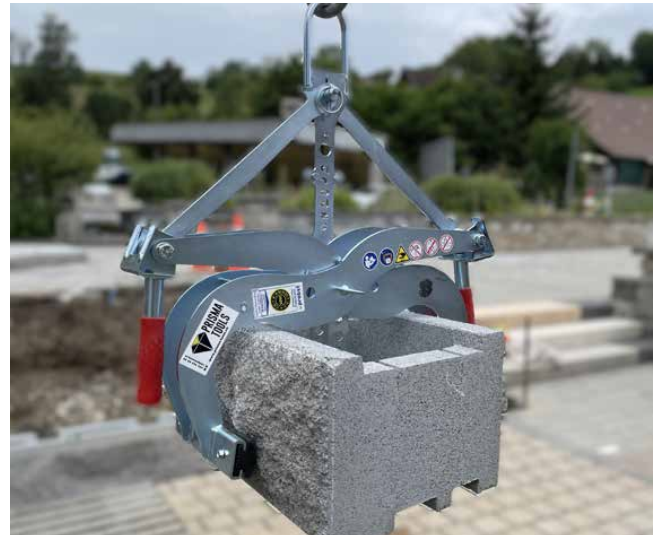
Bild 5: Versetzen mit Trittstufenversetzzange TSZ-Uni
