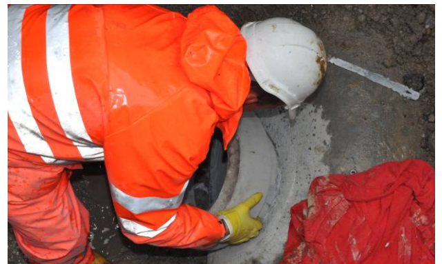
Bild 11: Klebeanschlussstück mit einer Drehbewegung einsetzen
