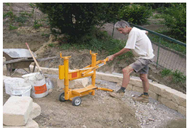
Bild 35: Arbeiten mit Steinspalter
