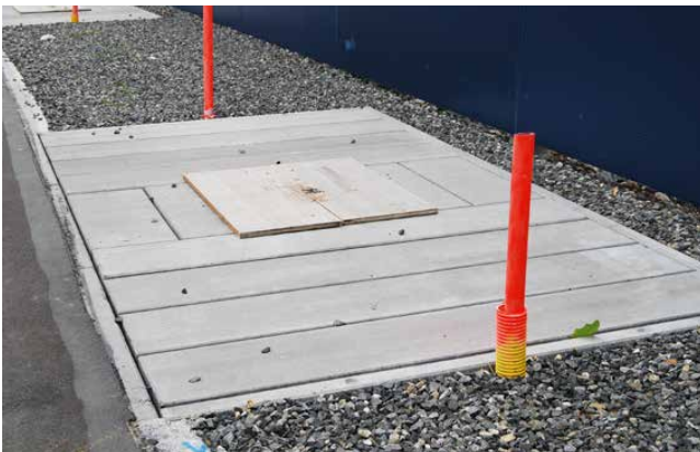
Einbau von Bewässerungs- und Belüftungsleitungen
