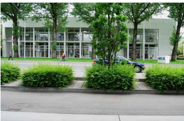
Einbau von Verbindungen zwischen den Baumgruben
