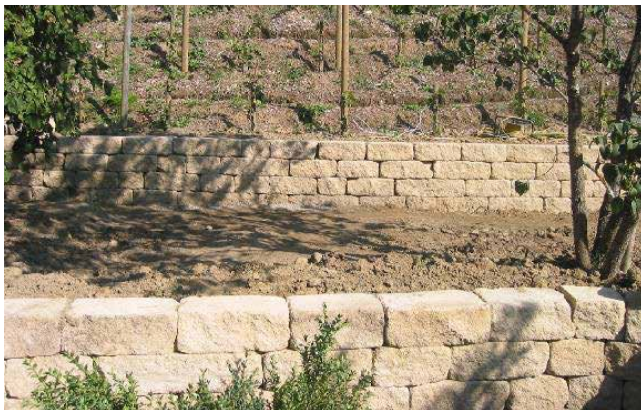
Bild 37: Senkrechte Trockenmauer
