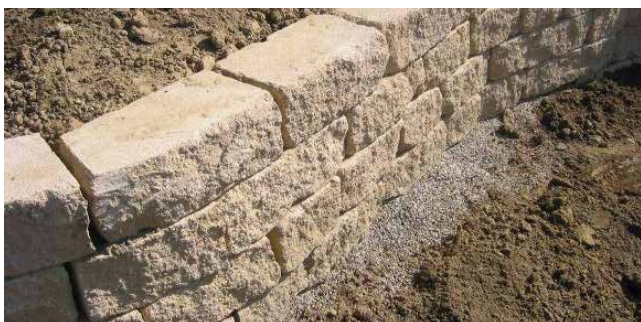
Bild 28: Kurvenbildung mit geraden Steinen
