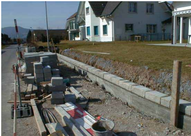
Bild 23: Versetzte erste Steinreihe in Betonfundament
