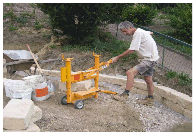
Bild 35: Arbeiten mit Steinspalter
