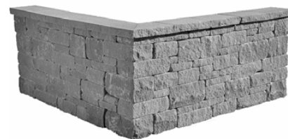
unregelmässiges Wechselschichtmauerwerk
