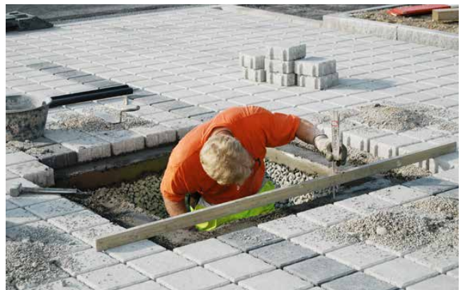
Erstellen eines Auflagers auf Fundamentrahmen
