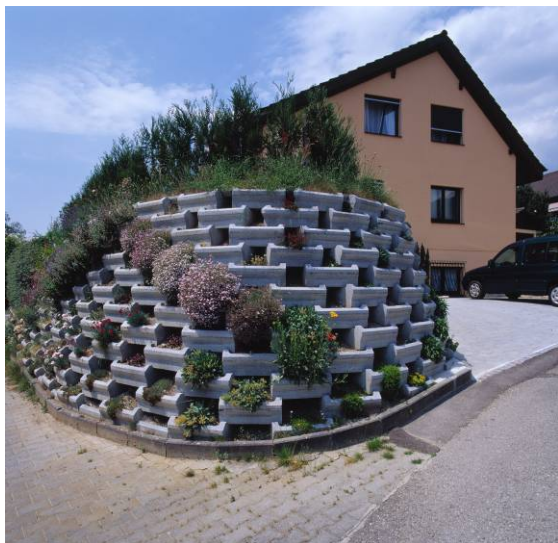
Bild 29: VERDURO® als Lärmschutzmauer
