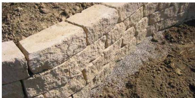
Bild 28: Kurvenbildung mit geraden Steinen
