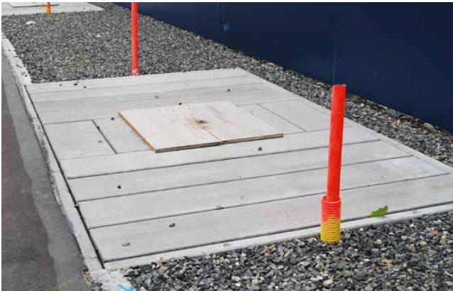
Einbau von Bewässerungs- und Belüftungsleitungen
