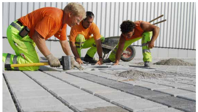
Versetzen der COMO Baumscheiben
