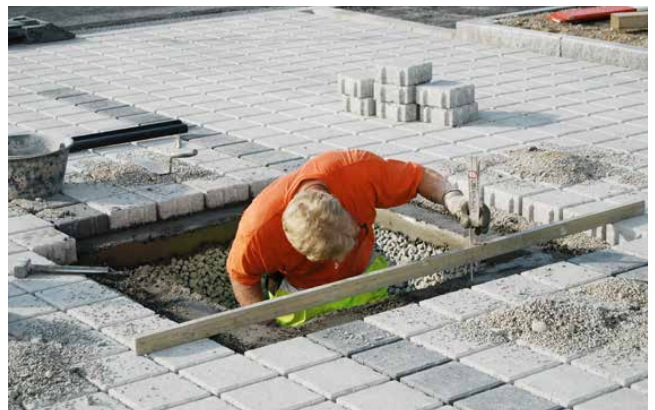
Erstellen eines Auflagers auf Fundamentrahmen
