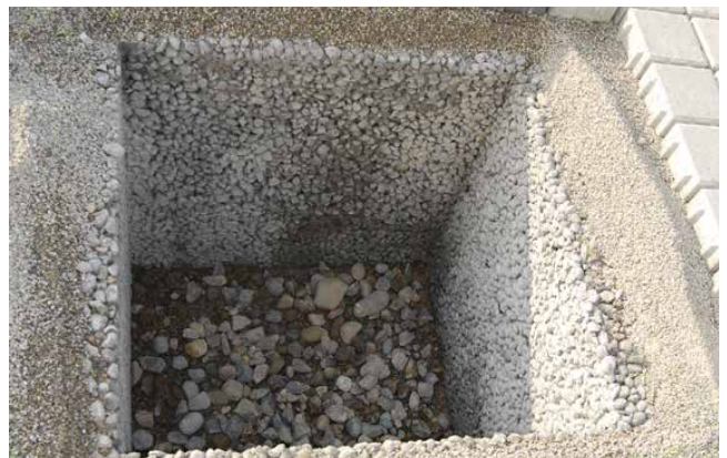
Erstellter Fundamentrahmen
