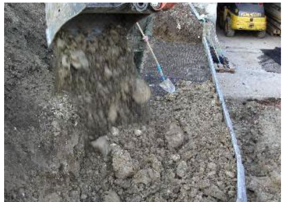
Bild 25: Hinterfüllen der zweiten 20 cm
