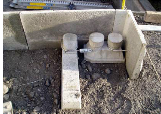
Bild 26a: Eckspanner parallel zum kleineren Schenkel montieren
