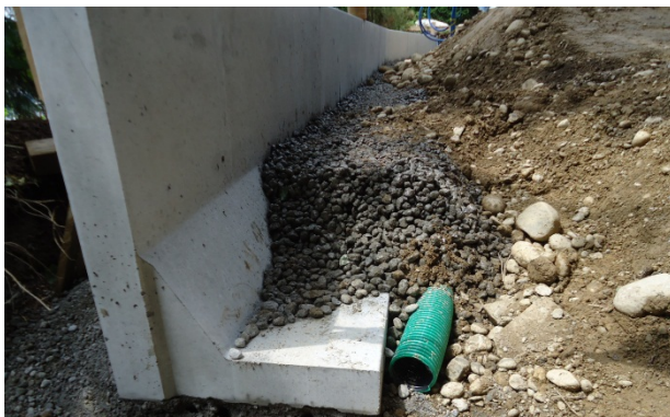
Bild 24: Einbau einer Sickerleitung
