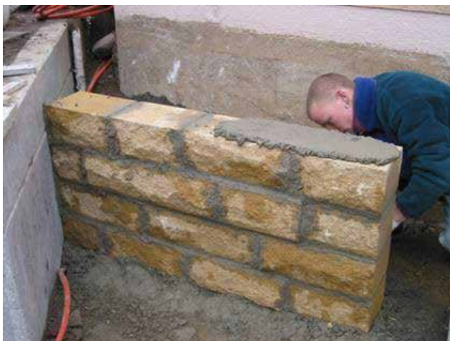
Bild 42 Aufbringen Mörtel für Abdeckplatte
