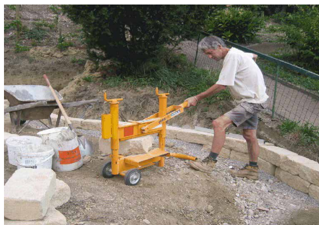
Bild 35: Arbeiten mit Steinspalter
