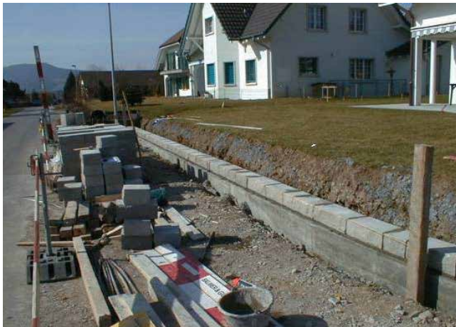
Bild 23: Versetzte erste Steinreihe in Betonfundament
