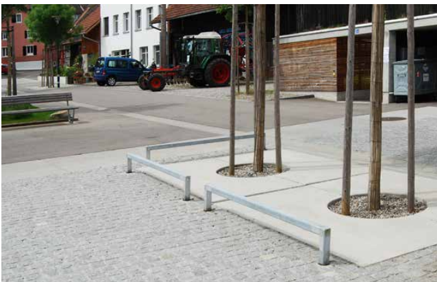
Montierte Radabweiser
