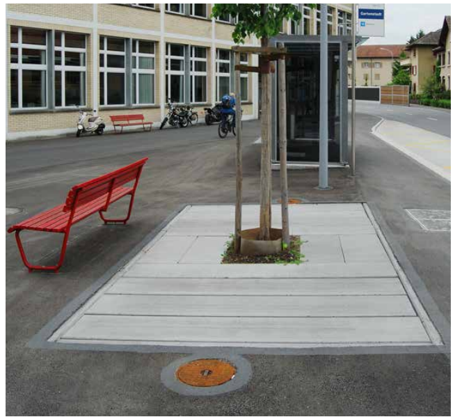
F+F Baumwurzelraumschutz, anthrazit eingefärbt
