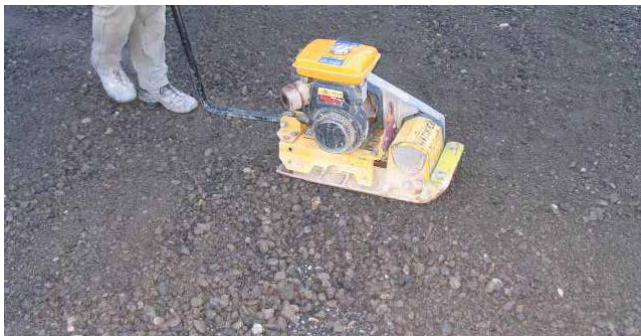
Verdichten der Fundationsschicht
