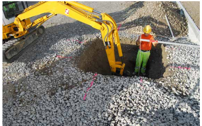
Erstellen des Pflanzloches
