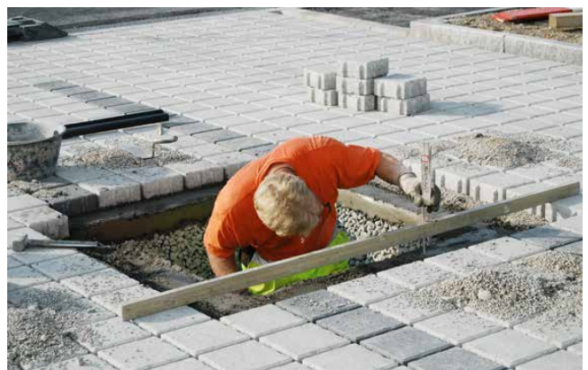
Erstellen eines Auflagers auf Fundamentrahmen
