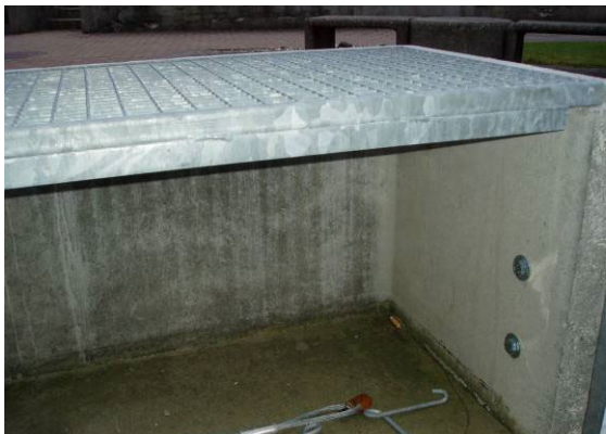
Bild 39: Verstärkte Gitterrostkante gegen die Hauswand
