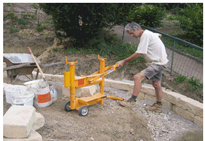
Bild 35: Arbeiten mit Steinspalter
