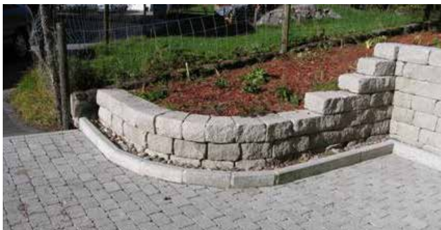
Bild 30: Maueraufbau mit SANTURO® Keilmauersteinen
