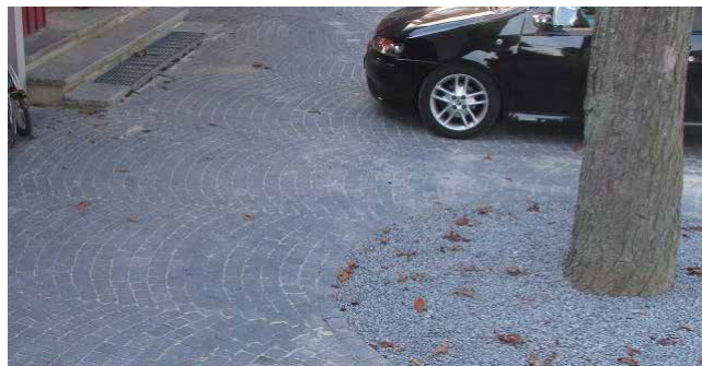
Anpassung bei einer Baumöffnung
