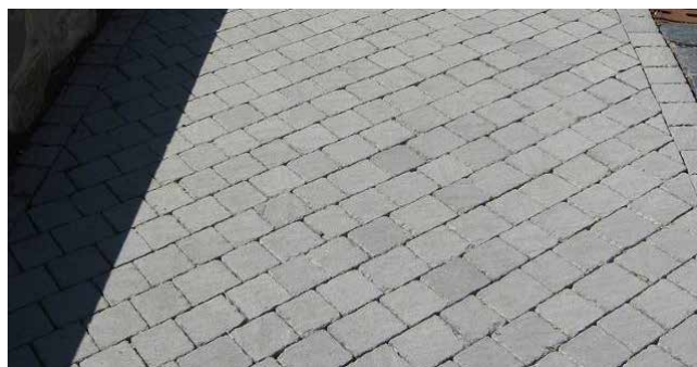
Pflasterfläche mit Passsteinen bei Randabschluss
