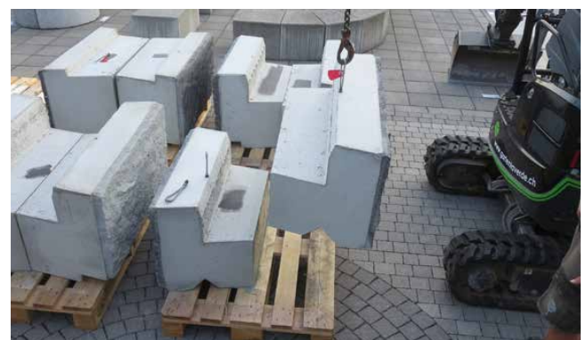
Bild 21 Werkseitig eingebaute Transporthülsen M16
